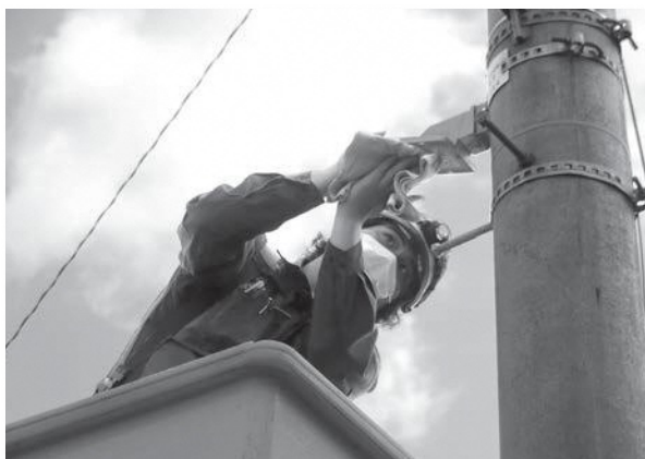
▲ 街路灯についたほこりや汚れをきれいに拭きあげていました
