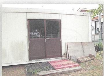
最初に建てられた倉庫は、コンテナを使用した、盆踊り用具を収納するためのもの。四方窓ガラスがあるので、盗難防止と光を入れるため、ベニア板を付けている。ベニアの板が古く、見栄えが悪いので張り替えた。
