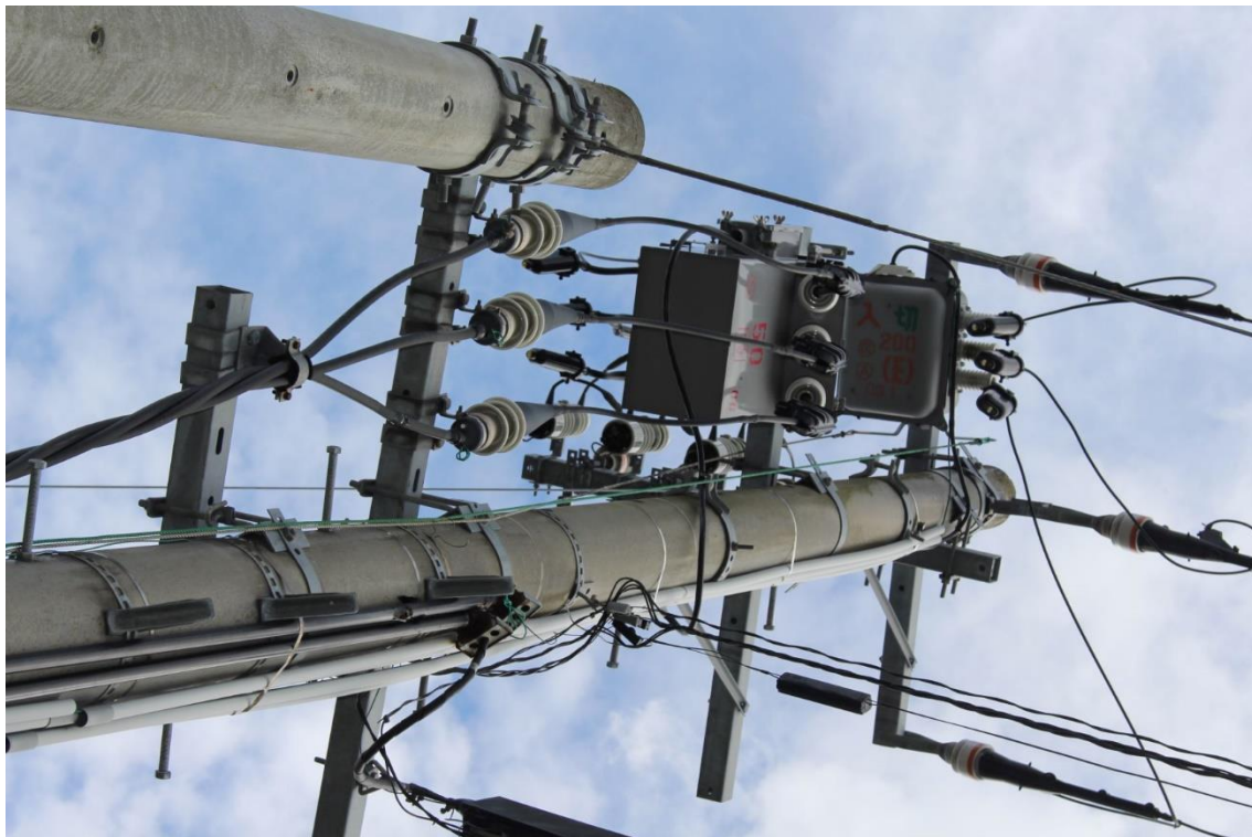
【拡大写真－気中開閉器】
