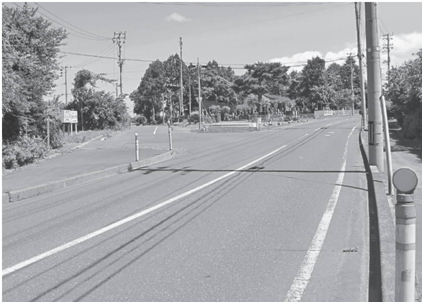
改良工事が行われる木ノ下地区の丁字路
