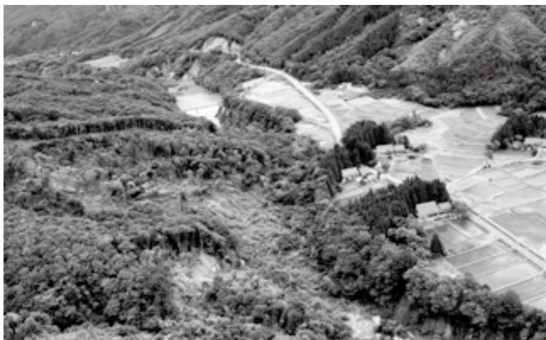
山全体が動いたような大規模な土砂崩れ（巖美町坂川地内）。およそ 50 万㎡の土砂が磐井川を埋めている（平成 20 年 6 月 14 日午後撮影）
