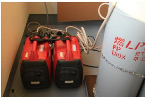
2 台の発電機で停電時も避難室内の電気を確保します。
