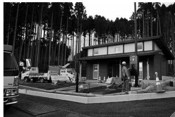
▲史跡公園の駐車場工事の様子。
