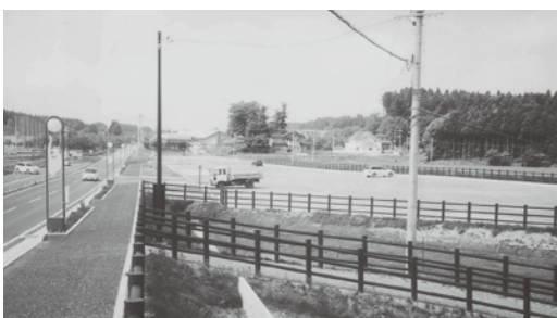
観光拠点として整備される駐車場工事
