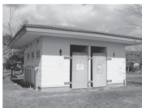
▲いちよう公園内のトイレ
