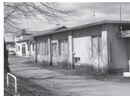
▲改修が予定されている一川目生活会館
