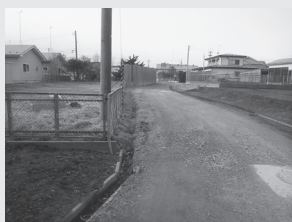
▲現在の藤ヶ森の側溝
