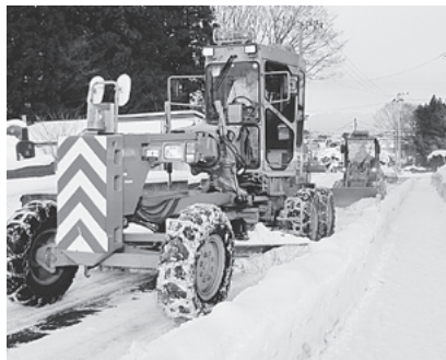
▲北部地区の再除雪の様子
