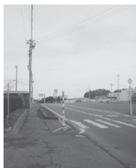
▲外灯がない横断歩道
