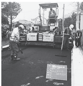
▲町道整備工事の様子
